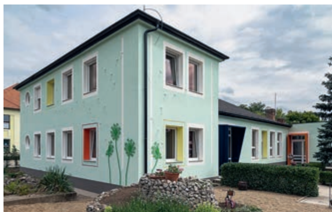
A dorogi Petőfi Sándor Óvoda homlokzati hőszigetelése
