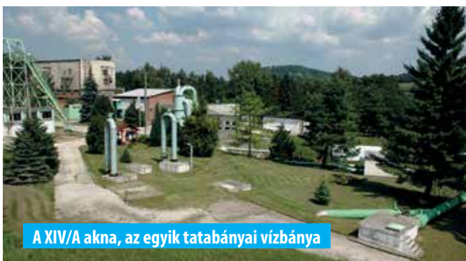
Az Északdunántúli Vízmű Zrt. Irányítóközpontja
